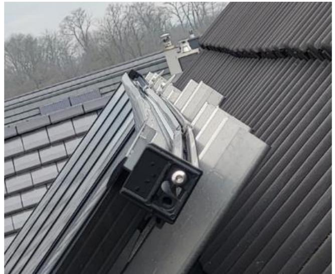
Außerdem können sich Befestigungsklemmen mit der Zeit lockern oder lösen, was ein Sicherheitsrisiko darstellt. Damit das nicht passiert, muss die Ausrichtung exakt nach Herstellerangaben erfolgen.
